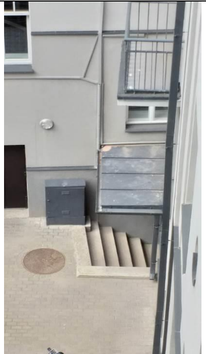
4.10.1.14.att. Ārējās dzelzsbetona kāpnes
