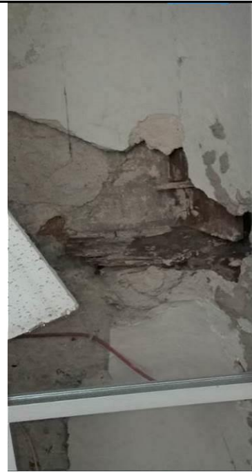
4.6.2.1., 4.6.2.2. Atsegtu pārsegumu bojājumi
