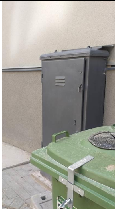
5.9.1.1.att. Elektrosadalne pie ēkas fasādes
