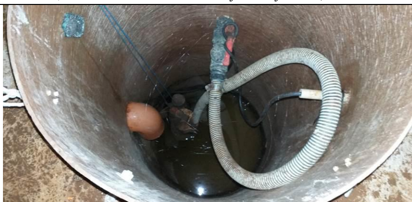
5.1.2.3.att. kanalizācijas ūdeņu atsūkņēšanas aka, ar sūkņi
