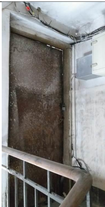
4.13.2.11.att. Ieejas durvis uz bēniņiem pilnībā korodēja, kāpnēs Nr.1
