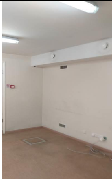
4.12.1.8. att. Linoleja segums ar nodiluma pazīmēm, ēkas pagrabstāvā
