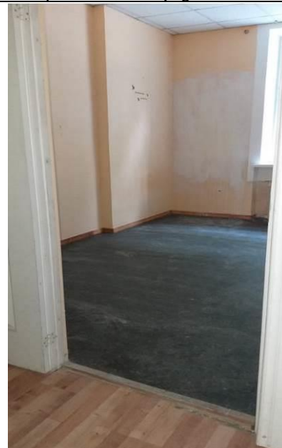
4.12.1.9.att. Linoleja segums ēkas pirmā stāvā biroju telpās
