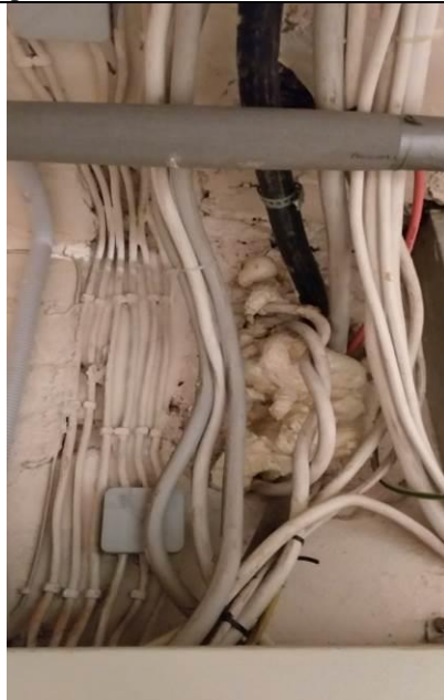
5.9.1.6. att. Kāpnēs gaismekļi bez plafoniem un sadales kārba bez vāka
