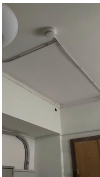
5.3.2.1.-5.3.2.3.att. Dūmu detektoru izvietojums
