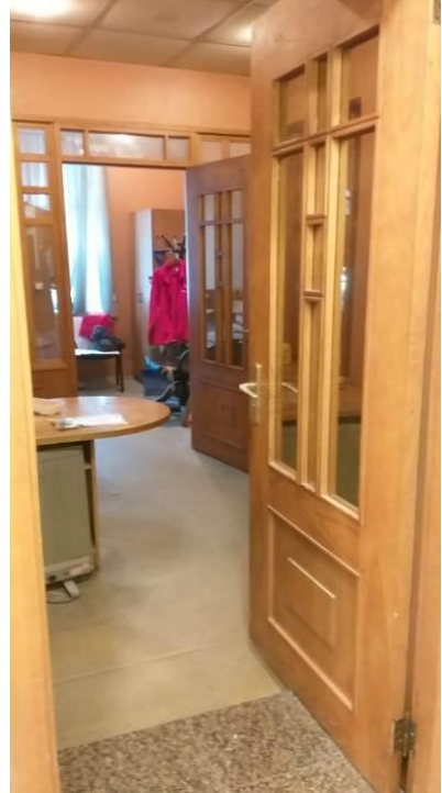
4.13.2.1.att.Finierētas koka durvis dežūrtelpā ēkas 1.stāvā
