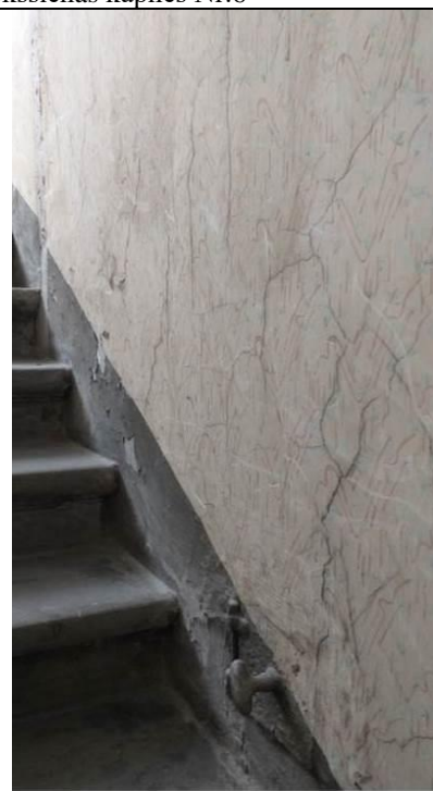
4.2.4.3., 4.2.4.4.att. Plaisu tīkls uz iekšsienām, kāpnes Nr. 6
