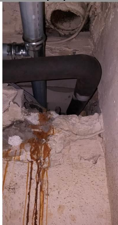
4.15.2.5.att. Atvērumi ēkas pagrabā, ūdens ievada telpa
