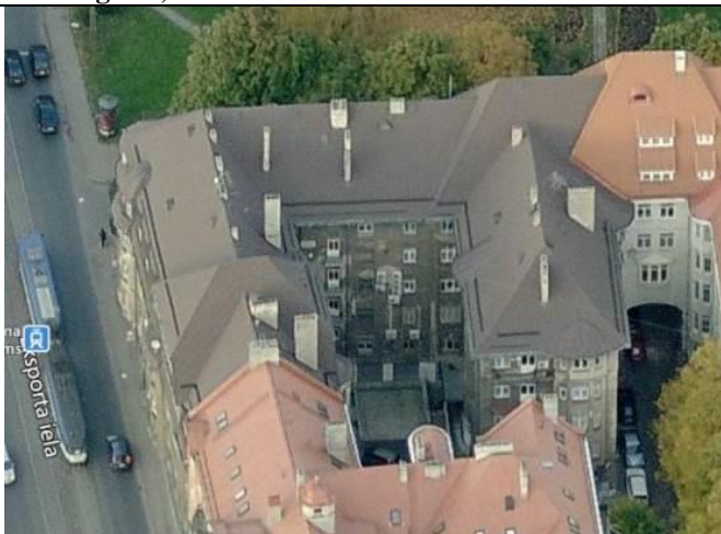
4.8.2.1. Att. Skats uz jumtu
