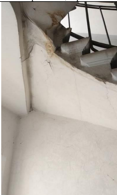
4.10.1.12.att., 4.10.1.13.att. Metāla siju un stiegru korozija, kāpnes Nr.6
