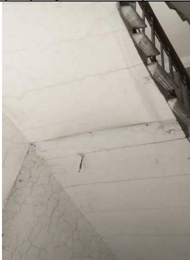
4.10.1.10.att., 4.10.1.11.att. Kāpņu laidumu plaisāšana, kāpnes Nr.6
