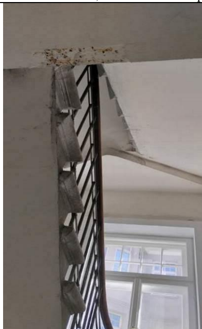
4.10.1.12.att., 4.10.1.13.att. Metāla siju un stiegru korozija, kāpnes Nr.6
