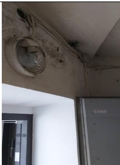
5.9.1.6. att. Kāpnēs gaismekļi bez plafoniem un sadales kārba bez vāka
