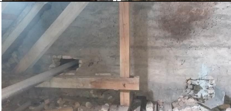
4.15.2.8.-4.15.2.10.att. Nehermetizētie atvērumi komunikācijām bēniņu telpu sienās
