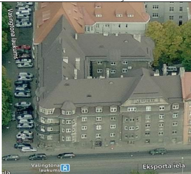
4.8.2.2. Att. Skats uz jumtu
