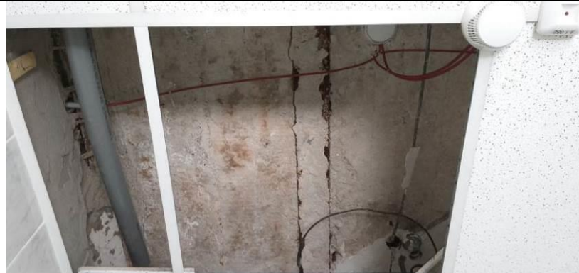
4.6.2.5. Pārsegums sanitārtehniskajā telpā
