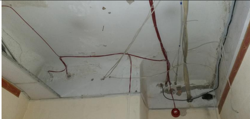
4.15.2.3.att. Atvērumi ēkas 1.stāva biroja telpās
