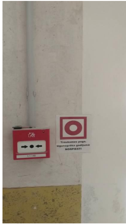
5.3.2.4.att. Dūmu detektoru izvietojums Trauksmes poga
