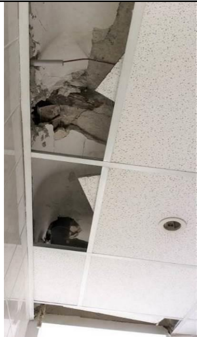
4.6.2.1., 4.6.2.2. Atsegtu pārsegumu bojājumi
