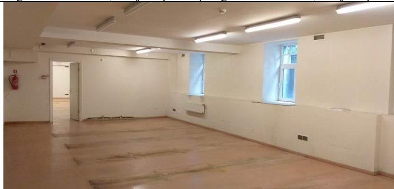
4.12.1.7.att. Linoleja grīda ar nodiluma pazīmēm, ēkas pagrabstāvā
