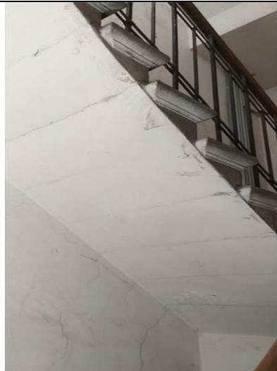
4.10.1.10.att., 4.10.1.11.att. Kāpņu laidumu plaisāšana, kāpnes Nr.6
